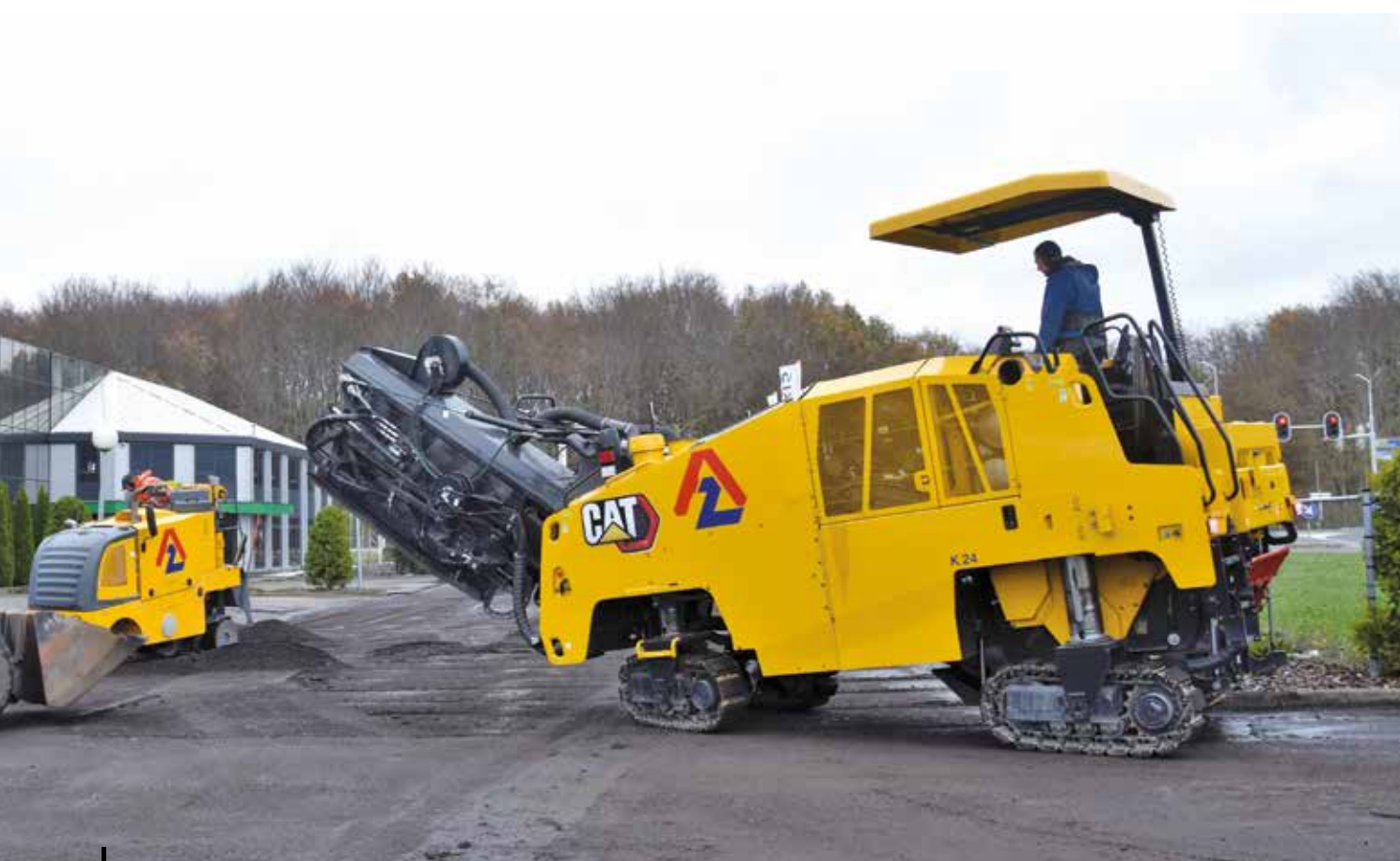
Op het project in Aalsmeer wordt ook een kleinere frees ingezet voor de randen en bochten plus nog een wiellader om het freesasfalt af te voeren.
