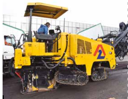
De rechter rups is verstelbaar en wordt hier naar buiten geplaatst om de freesmachine stabiel te maken.
